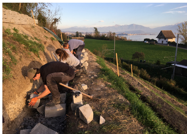
Trockenmauerbau Auenhof (Quelle: NNP)
